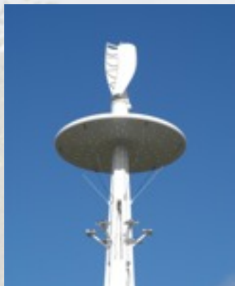
WS-2B, Baglan Energy park, Etelä-Wales, Englanti.
